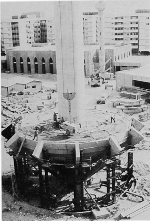
Bild 8 Der Hochbehälter nach Abschluß der Betonierarbeiten
