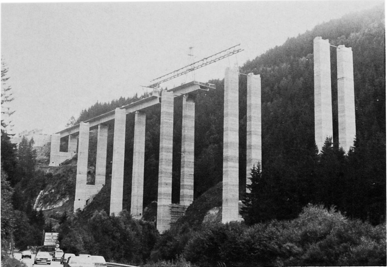
Bild 3 Montage der Brückenfertigteile (Segmente)
