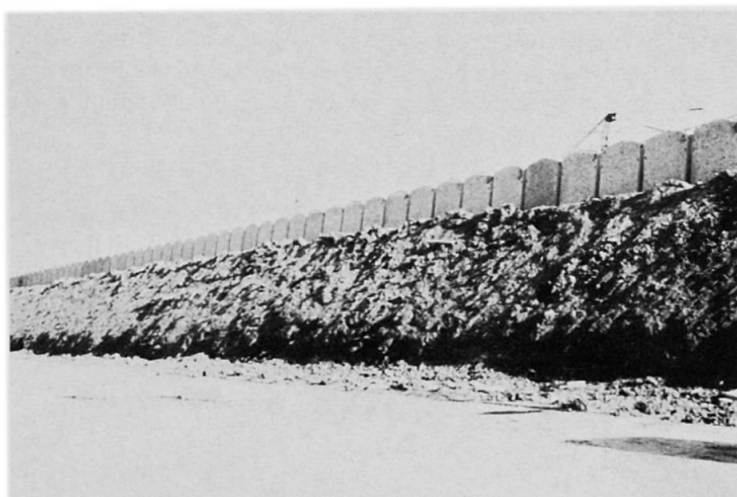
Butte de terre réalisée le long de l'autoroute A86 à Gennevilliers
