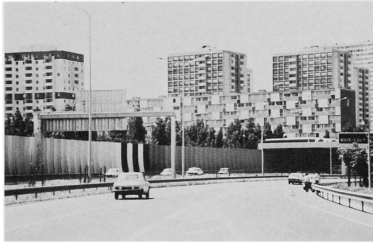
Ecran en béton armé réalisé le long de l'autoroute A86, dans la traversée de Colombes.
