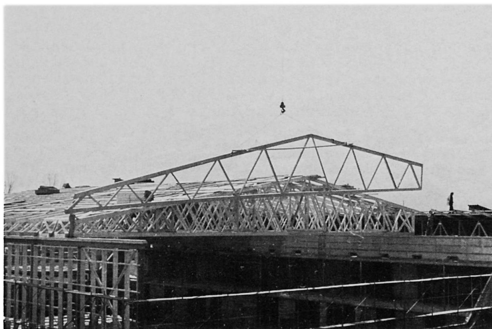
Bild 4 Fachwerkbinder für Sporthalle (27 m)
