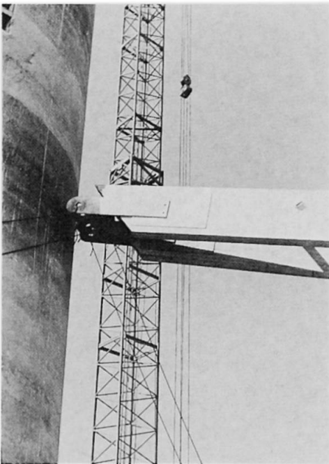
Bild 5: Anschlussdetail eines Dachsegmentes im Auflagerbereich des Turmes
