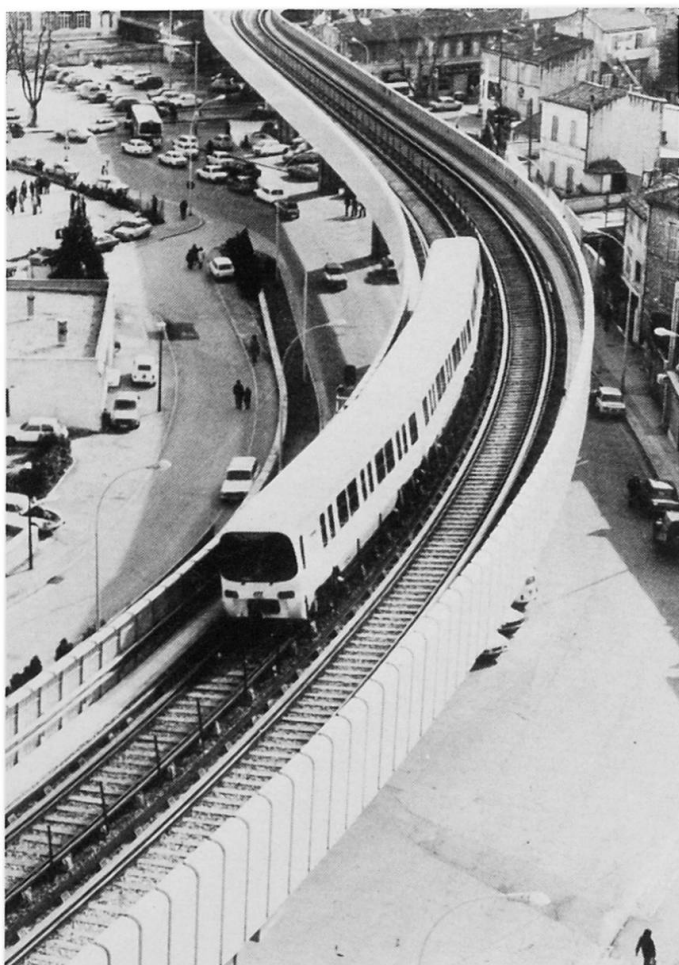
Fig. 3 Le viaduc de La Rose
