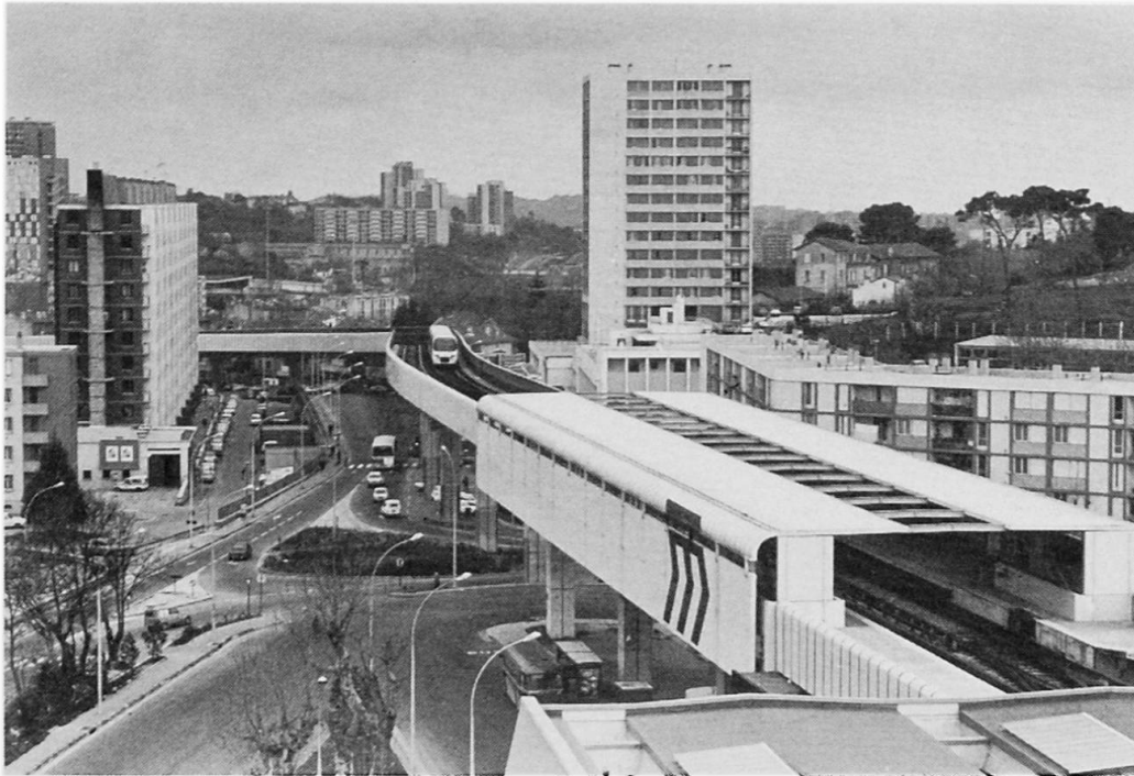
Fig. 5 Le viaduc et le terminus de La Rose
