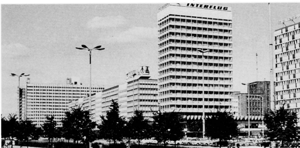
Fig. 10 Verwaltungsbauten SK-Berlin in Berlin/Alexanderplatz
