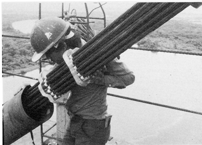
Figure 9 : Enfilage de torons.
