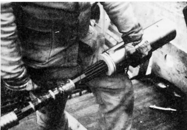
Abb. 6: HLV-Spannglied mit 19 Stäben
