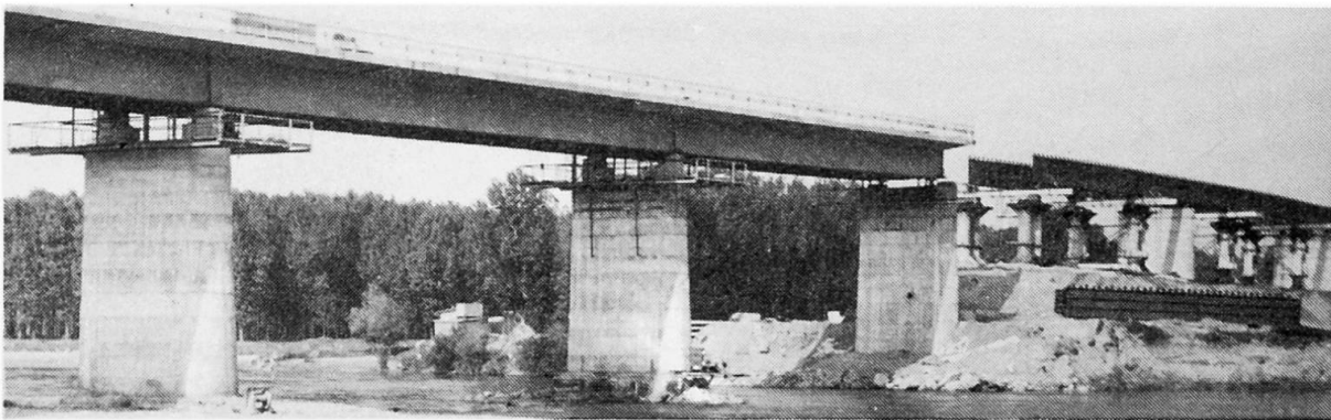
Fig.12. Pont à Stoenești - phases d'exécution
