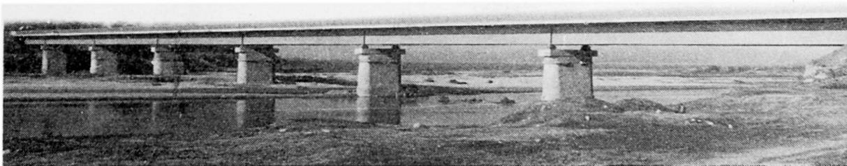
Fig.8. Pont rénové en 1976 sur l'Olt à Stoenesti
