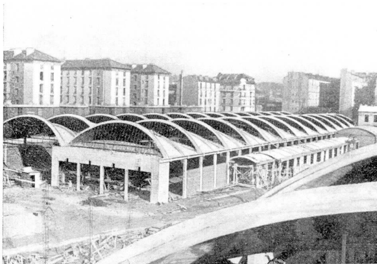
Fig. 1. Vue d'ensemble du Hall d'Entretien. — Gesamtansicht der Halle für Unterhalt. — General view of the Assembly Hall.
