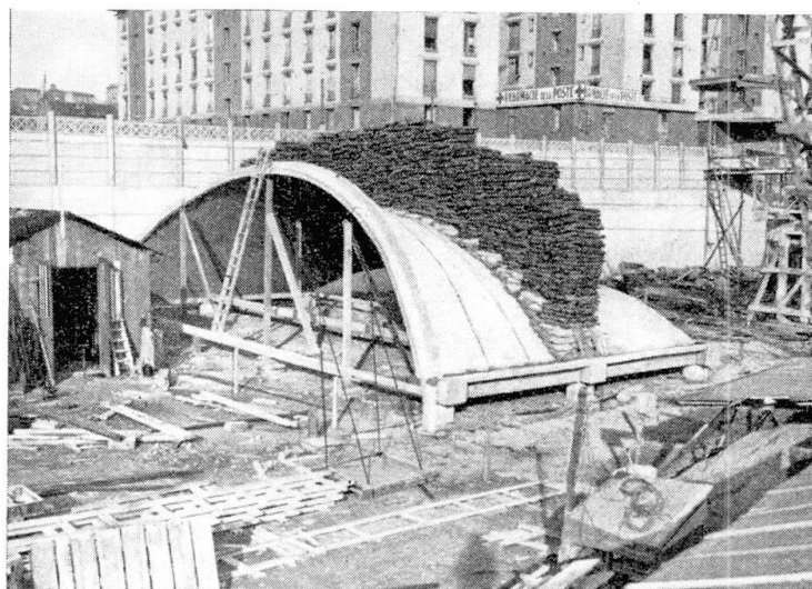
Fig. 5. Vue de la voûte au cours du deuxième essai. — Ansicht der Schale im Verlauf des zweiten Versuches. — View of shell during 2nd test.
