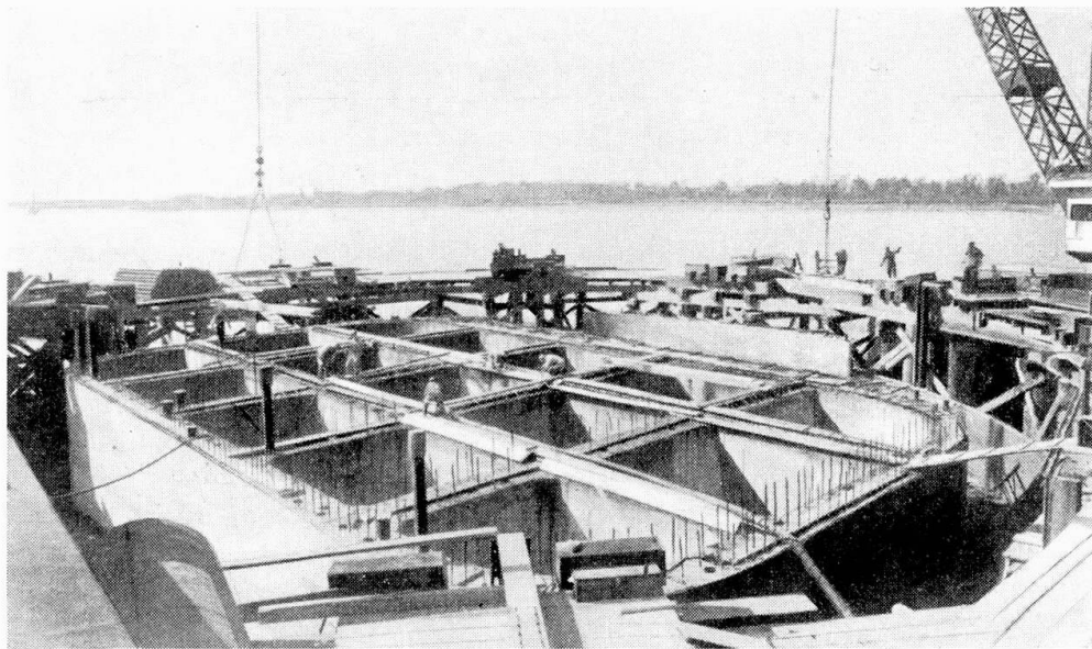
Fig. 3. Mississippi River Bridge, New Orleans, La. Pfeiler III bereit zur Ausbaggerung. Caisson III prêt à être immergé.
