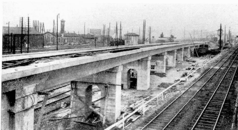
Fig. 5. Zufuhrviadukt in der Plaine-St-Denis — Estacade d'accès, à la Plaine-St-Denis — Access viaduct in the Plaine St.-Denis.
