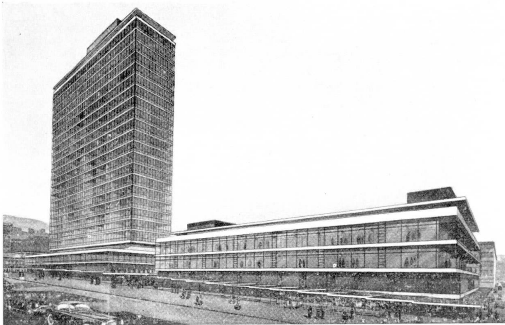
Fig. 25. Immeuble de 28 étages à Ankara.
