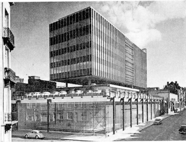
Fig. 2. Geschäftshaus Ieteren Frères in Brüssel. Unverkleidete Stahlkonstruktion.
