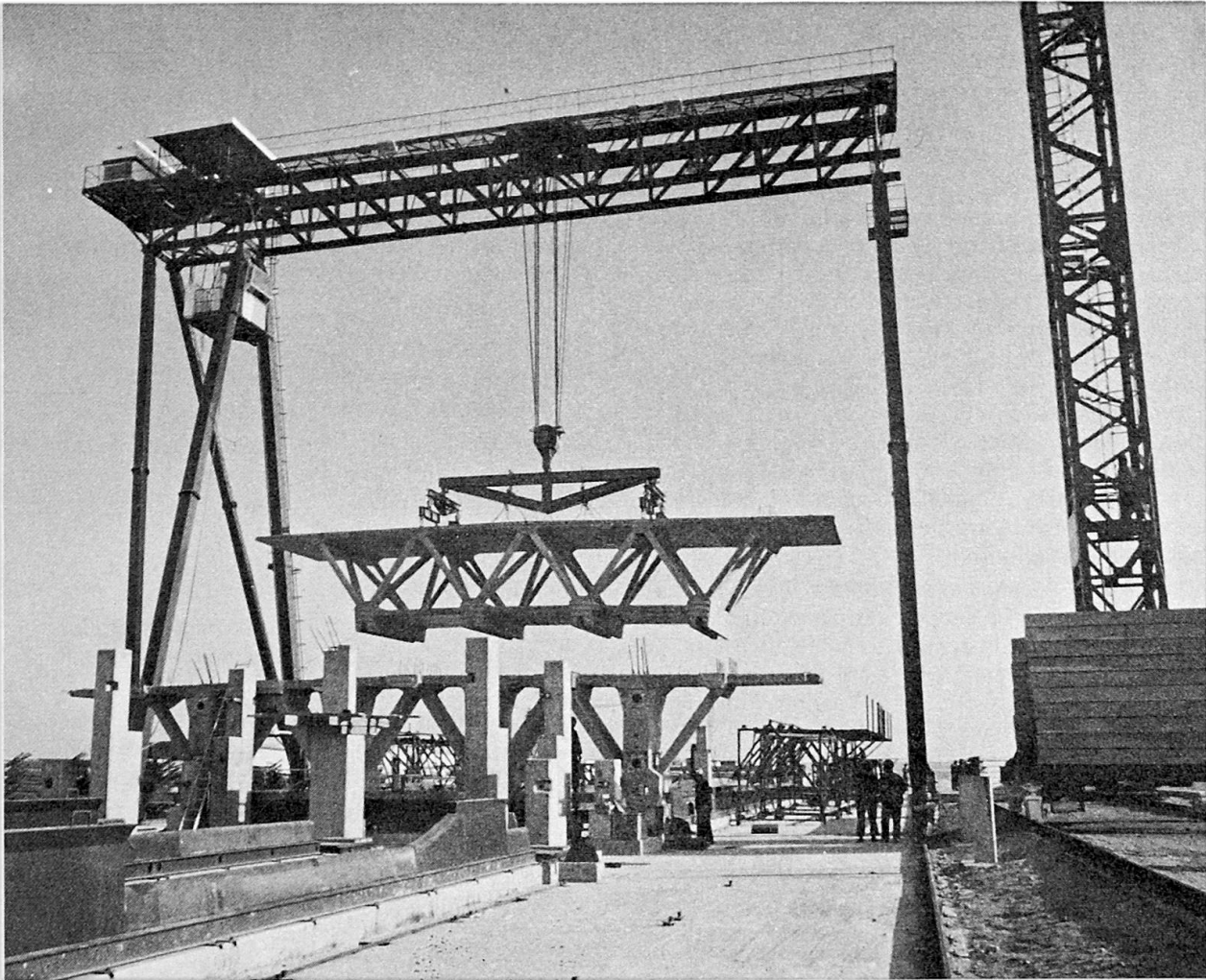
Voussoir préfabriqué du pont de Bubiyan (Koweït)
