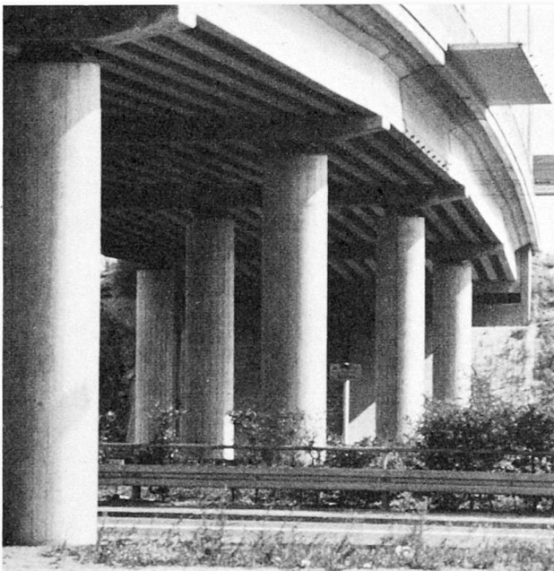
Bild 8: Hochstrasse Mühlheim b. Offenbach
