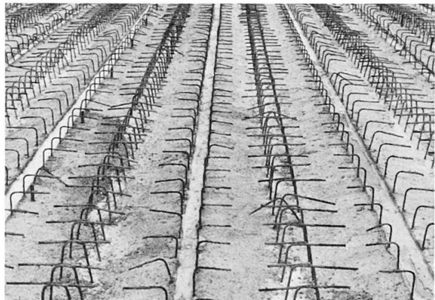
Bild 6: Fotografie der Verbundbügel zwischen Ortbeton und Fertigteilen
