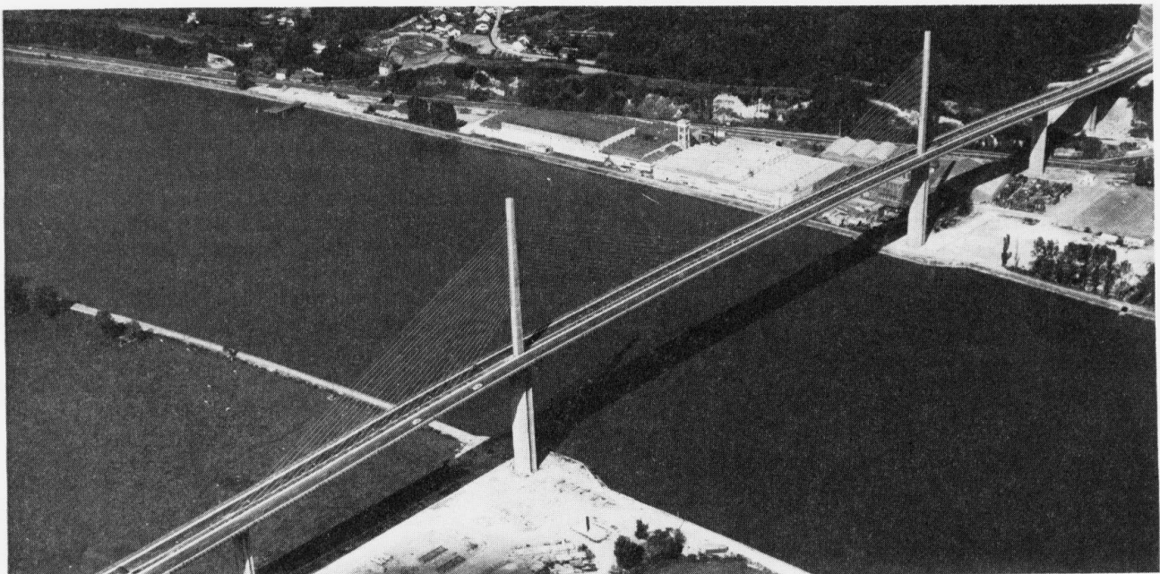
Fig. 6 - Vue de l'ouvrage terminé
