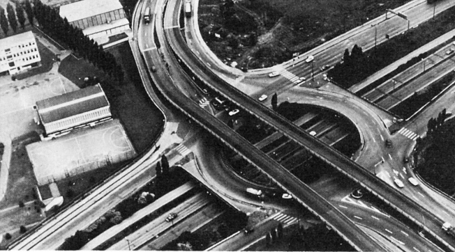
Autoponts sur le boulevard périphérique de Lille - France
