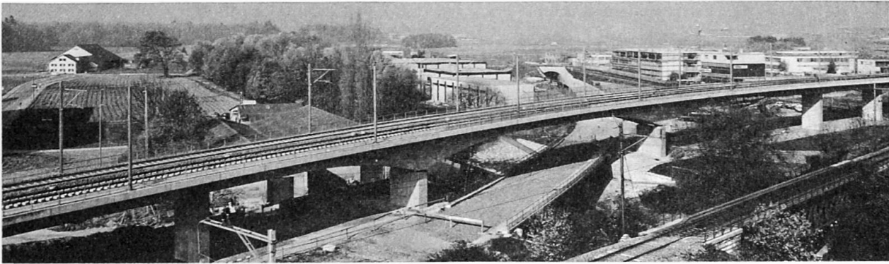
Die Eisenbahnbrücken über die Glatt, mit – unten – der neuen Flughafenlinie
