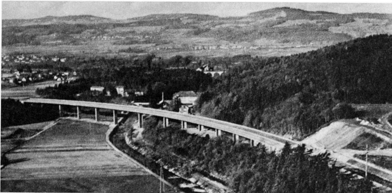
Flugaufnahme des gesamten Bauwerkes
