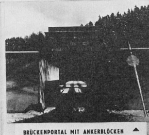
▲ BRÜCKENPORTAL MIT ANKERBLÖCKEN ▲
