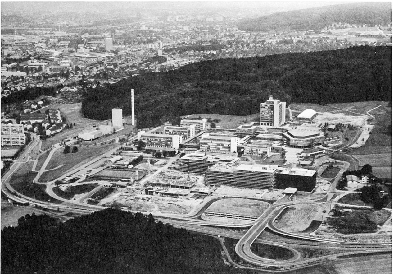
Flugaufnahme, Bauzustand Sommer 1974
