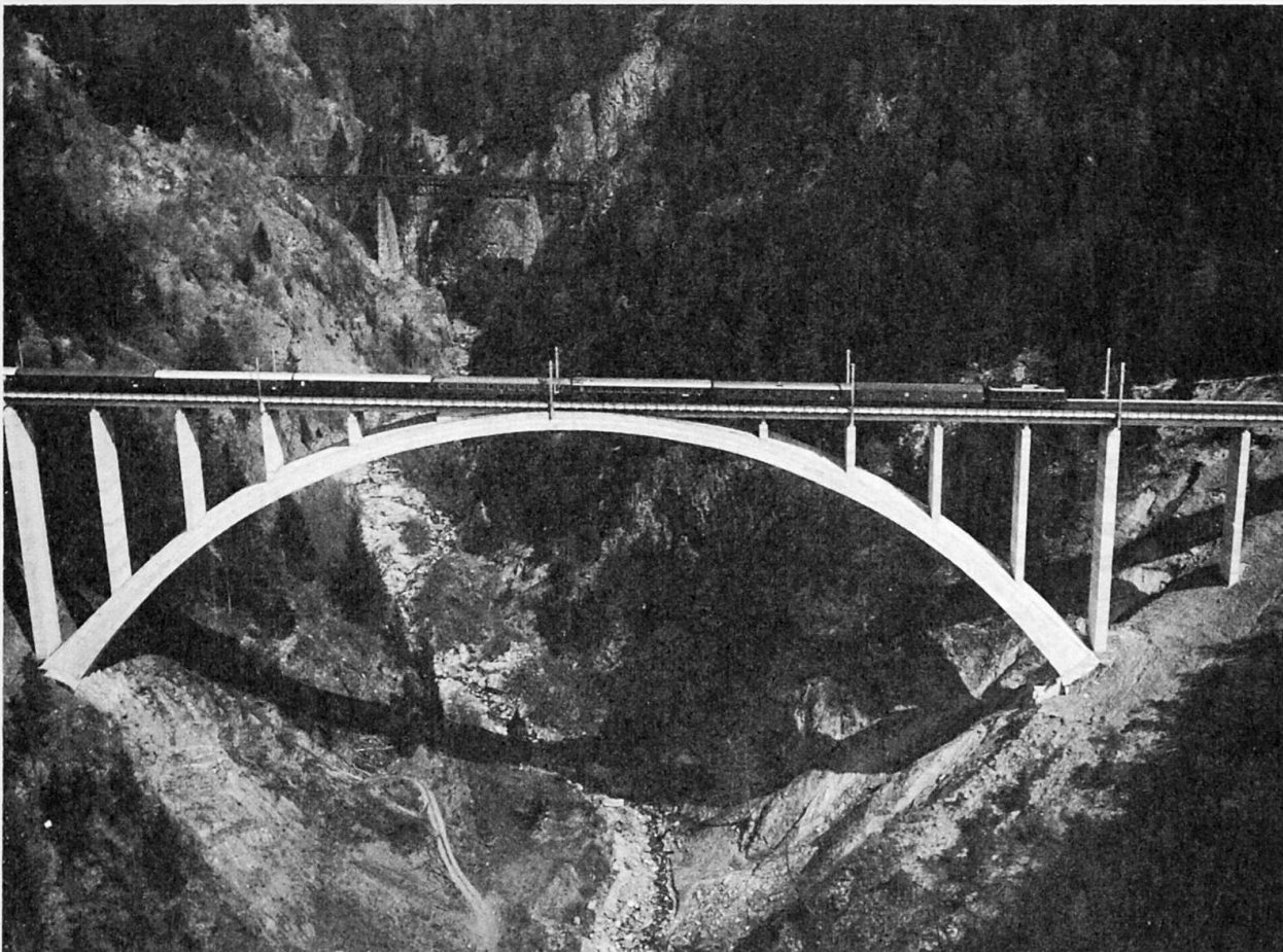
Pfaffenberg-Zwenberg-Brücke, im Hintergrund das alte Objekt zur Verbreitung freigegeben mit Zl. 07795 des Bundesministeriums für Landesverteidigung der Republik Österreich
