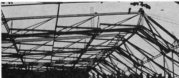
Bild 4 Haupttragkonstruktion – Bauzustand (Foto: Ch. Andoh)
