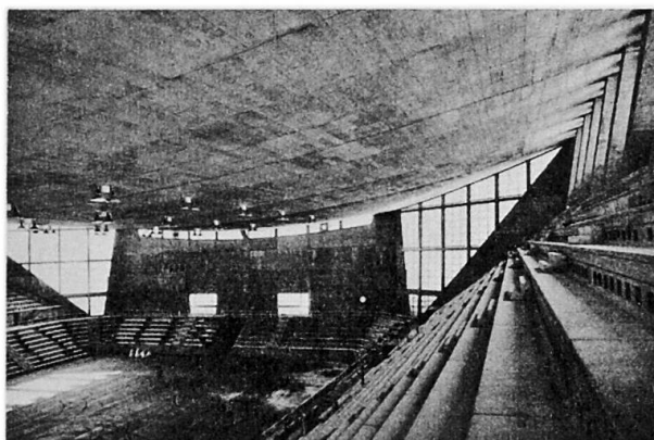
Innenansicht an Längswand, Diagonalfenster und Binder
