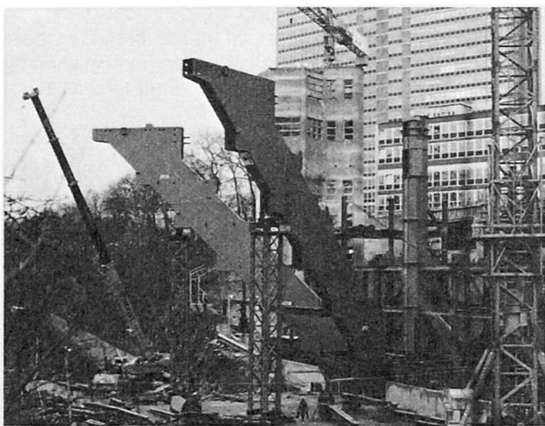
Fig. 2 Montage début mars 1979 des deux colonnes-caisson (29,8×3,5×0,9 m) dans l'encorbellement central
