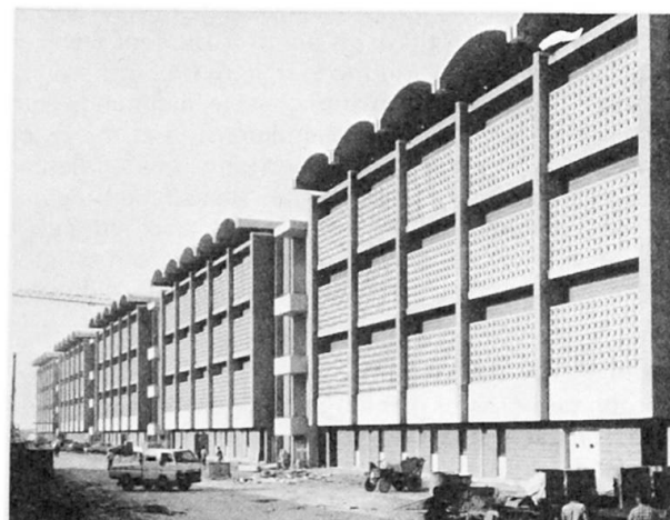
Bild 3 Fassade mit Schattengittern
