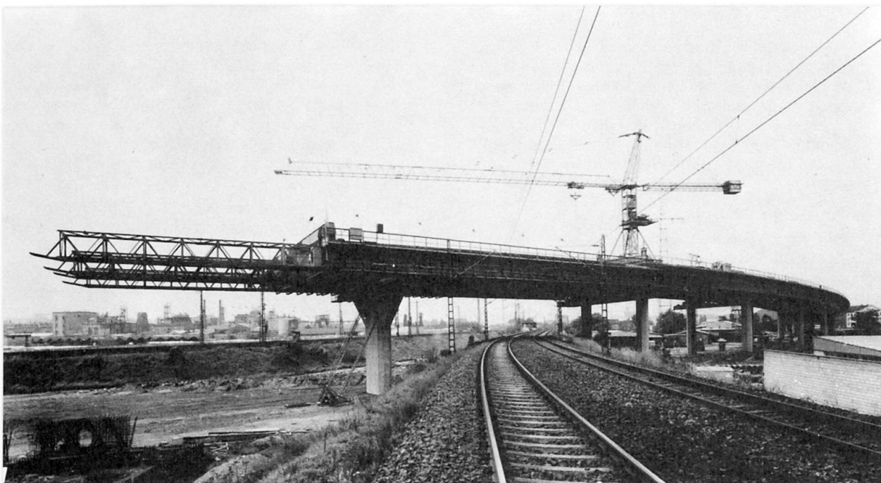
Bild 1 Verfügbare Operationshöhe über Bahnlichraum = 0,6 m
