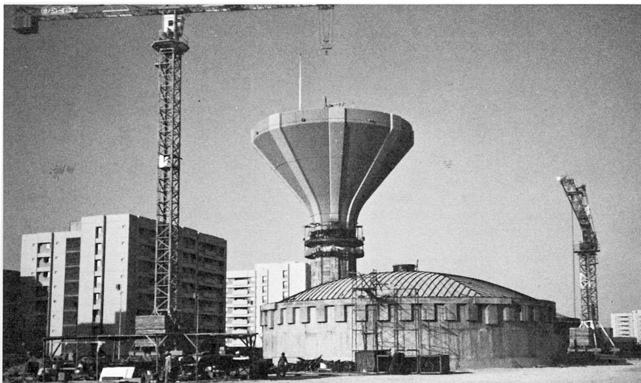
Vue d'ensemble en début de levage
