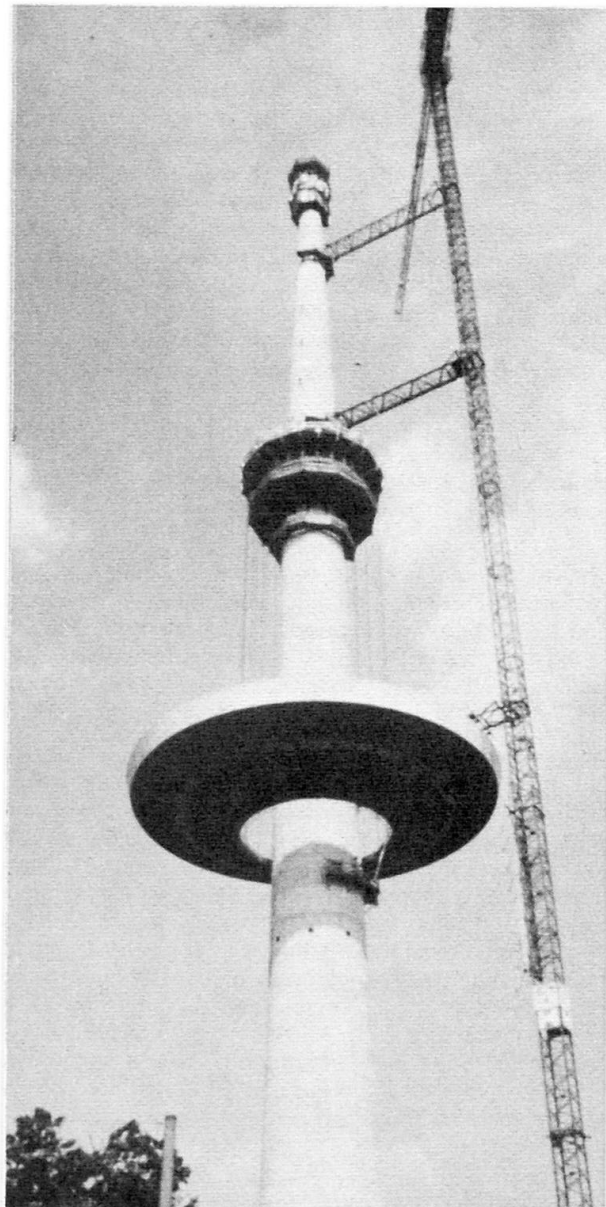
Bild 2 Hochziehen der 1200 Tonnen schweren Kegelschale
