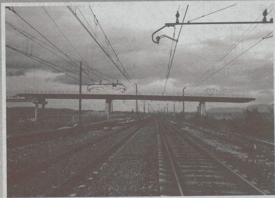
Cavalcavia ferroviario - n. 3 luci da 50 mt. - peso ton. 250
