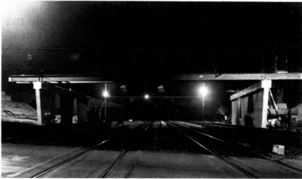
Pose des poutrelles longues de 43 m
