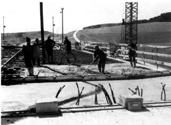
Bild 3 Die Vakuumbehandlung des Betons mit Tremix Vakuumausrüstung
