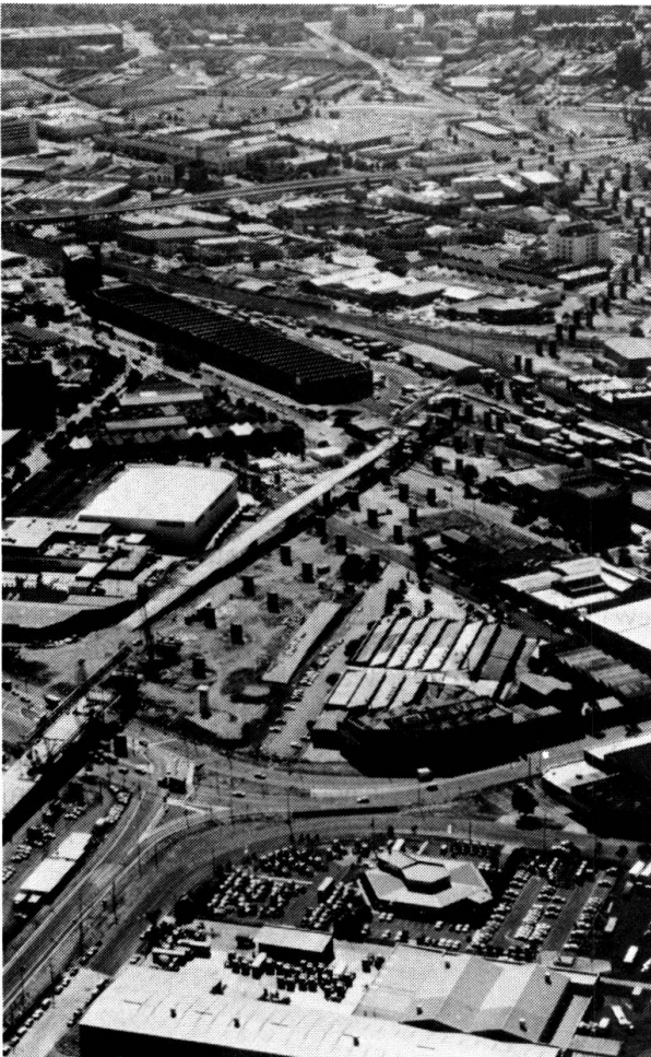
Vue générale en phase de construction
