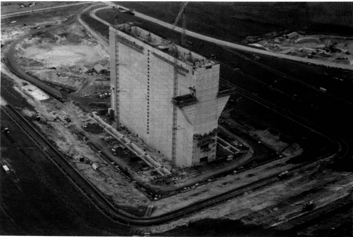
Vue du chantier, avril 1987
