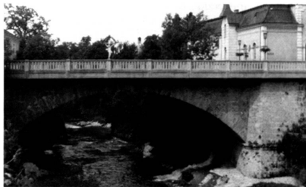
Bild 3 Brücke über der Grossen Erlauf in Purgstall, 1988
