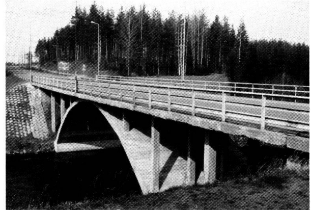
Fig. 1 The Käyräjoki bridge before repairing
