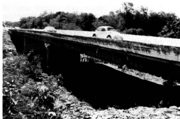
Vue générale après travaux de renforcement. Noter les étriers verticaux tendus.
