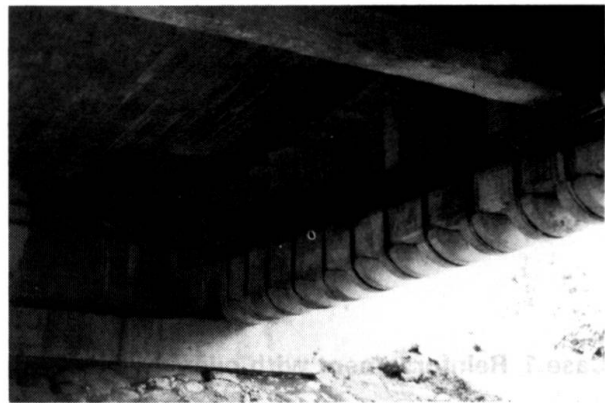
Précontrainte extérieure de renforcement – Câbles longitudinaux et étriers tendus.
