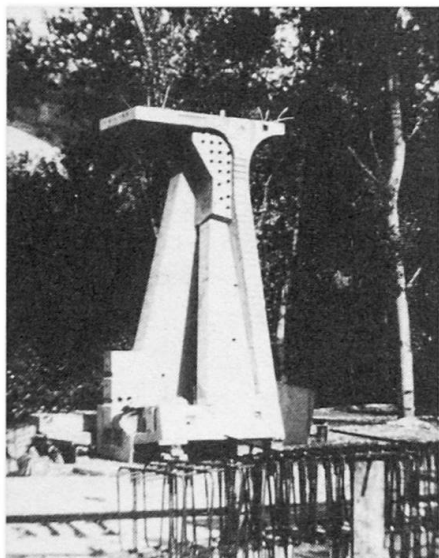
Photo 3 - Sermenaz viaduct. Precast web of an on-pier voussoir.
