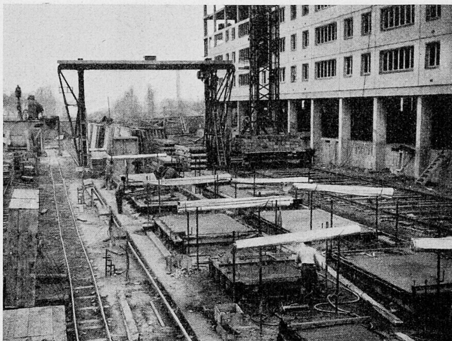
Fig. 2 - Préfabrication foraine desservie par portique et grue (Balency).
