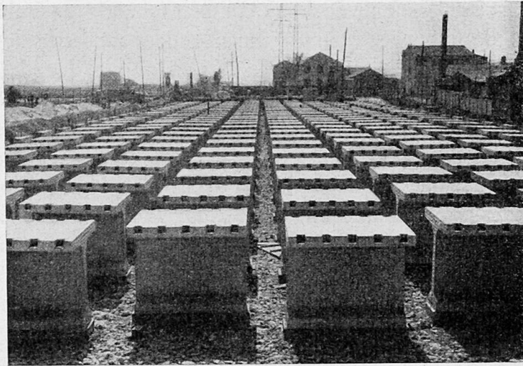
Fig. 10 - Park de stockage des douelles pour la gare souterraine de Barcelona.
