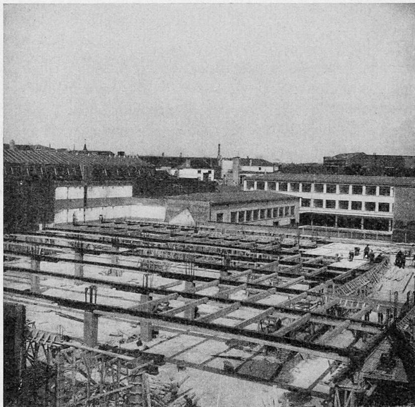
Fig. 1 - Grand Garage du Vieux Marché aux Grains à Bruxelles. Mise en place des poutres secondaires préfabriquées en béton armé sur les semelles des poutres Préflex de 20 m. Les coffrages de la dalle coulée sur place, s'appuyent sur les poutres secondaires de 6,60 m.
