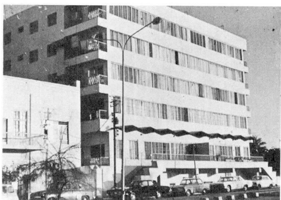
Bild 8: Wohnhaus in Bagdad
