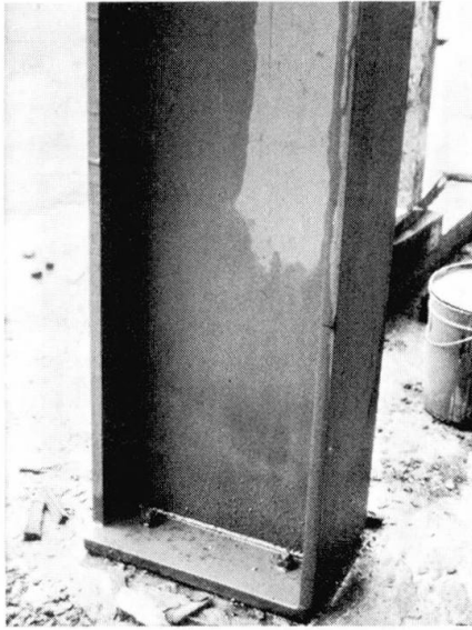
Bild 11a Angeschweisste Fussplatte
