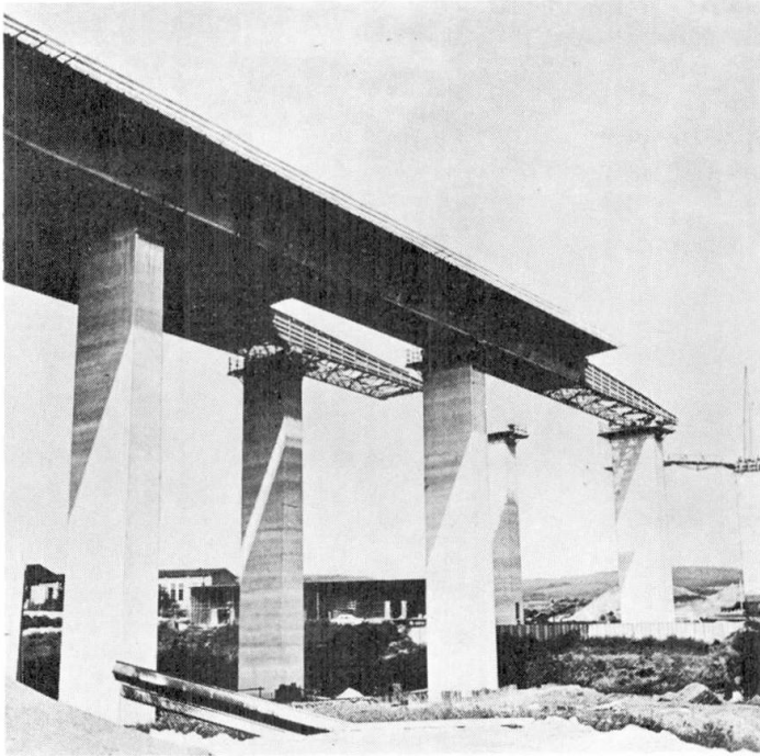
Fig. 13 Talbrücke Gerlingen - Taktschiebeverfahren
