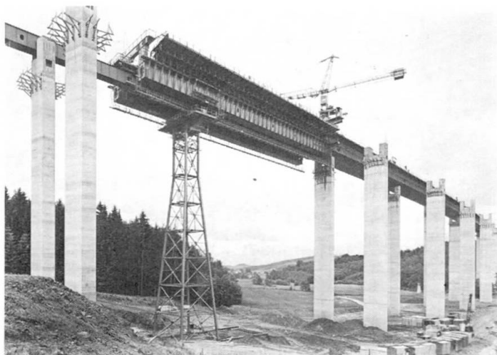
Fig. 12 Döllbachtalbrücke - Vorschubrüstung mit Zwischenstütze
