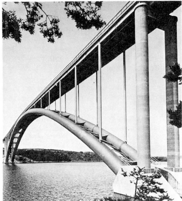
Tjörnbrücke in Schweden (1960)
