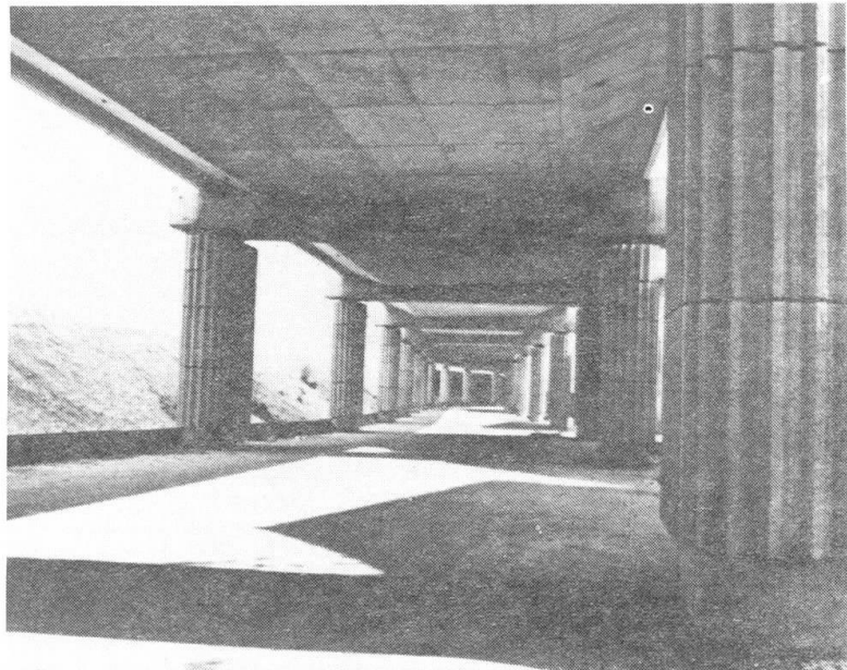
Fig. 6 : Viaduc et voie routière de Bougainville
