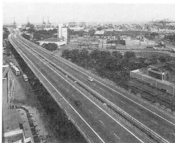
Fig. 2 Vue générale de l'ouvrage
