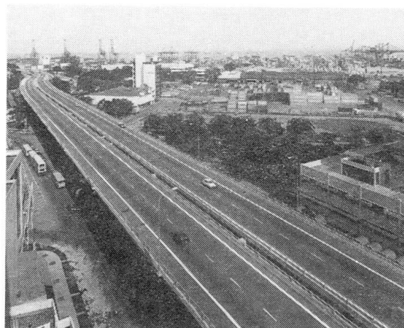
Fig. 2 Vue générale de l'ouvrage
